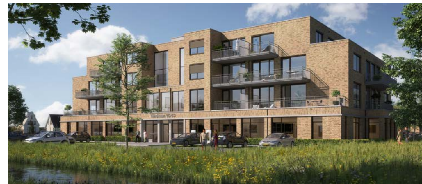
Hier ziet u de zijde met de entree voor de appartementen in het midden van het gebouw.
